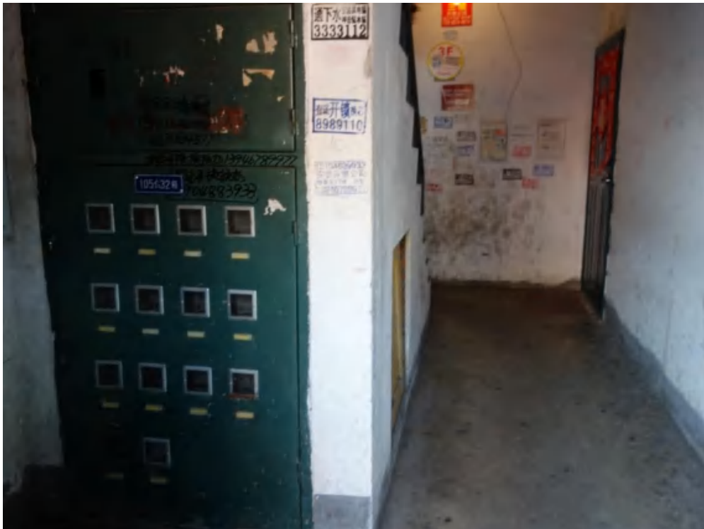
楼梯间已有电表
